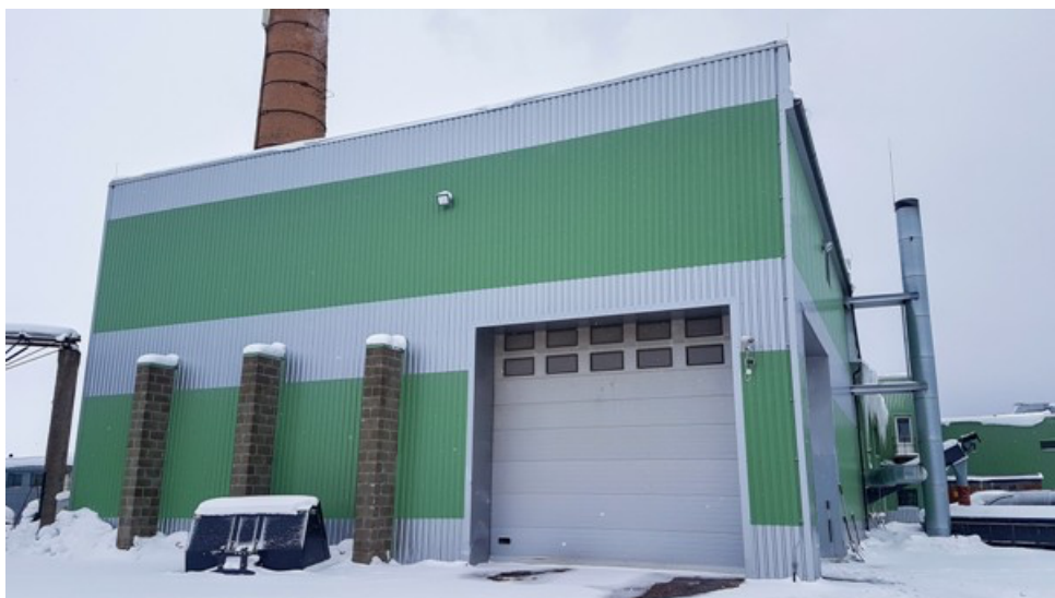
Joonis 3.1 Renoveeritud Haljala katlamaja, vaade kütuselao poolt. Foto Ü. Kask
