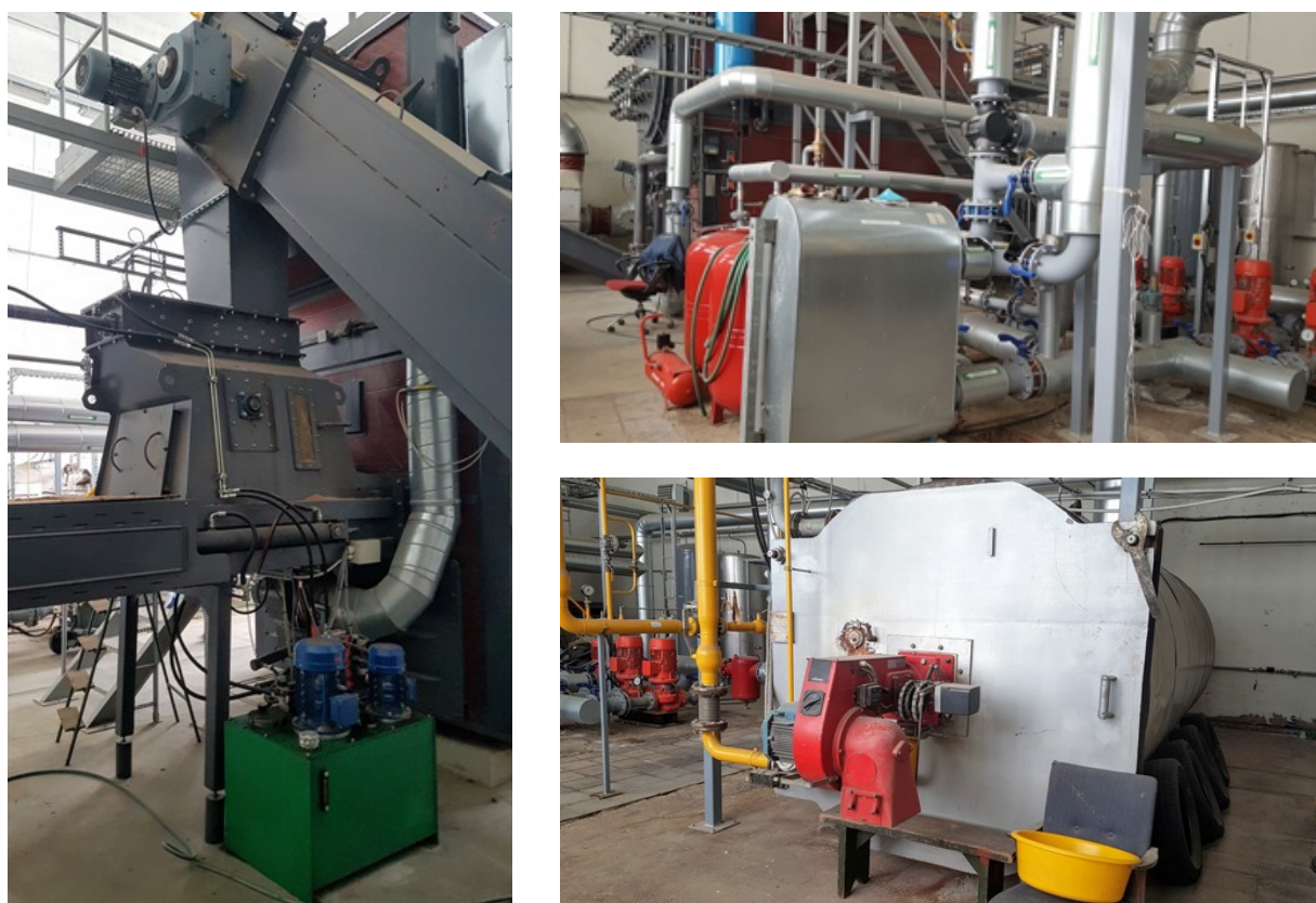
Joonis 3.2 Vasakul: Haljala katlamaja sisevaade, taamal uus hakkpuidu katel. Paremal ülal: vaade biokütusekatlale KAPAK1500 kütuse sisseande poolt. Paremal all: gaasikatel RW300. Fotod Ü. Kask
