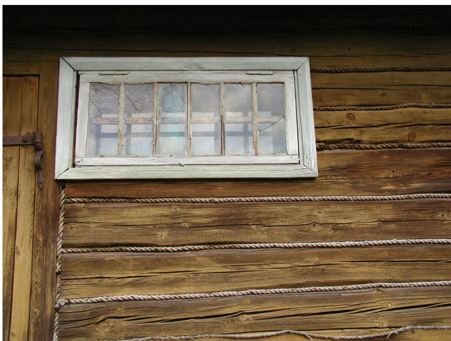
Vana palkhoone puidu struktuur on omaette vaatamisväärsus. Värvimata puit säilib kaua kui seda on töödeldud linaõliga ja majal on korralik vihmaveesüsteem.
